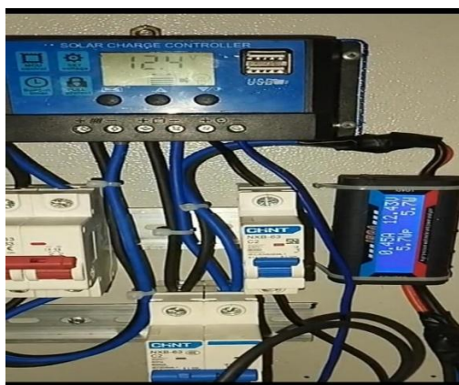
Gambar 6. Kondisi saat Bar pada SCC masih penuh
